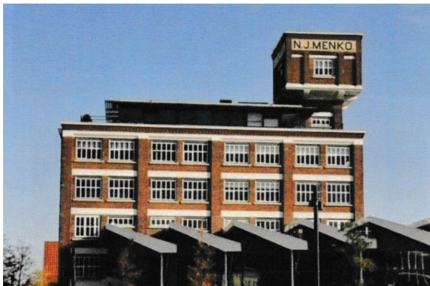
Afb. 1: voormalige fabriek met watertoren van de firma N.J. Menko.
