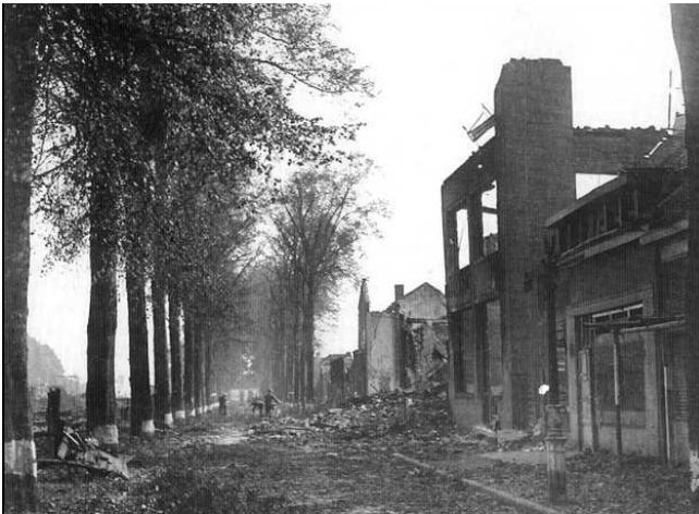
Afb. 9: Dit bleef over van de PAZO-schoenfabriek aan de Spoorlaan in Oisterwijk na het bombarderen van een munitietrein in september 1944 6)
