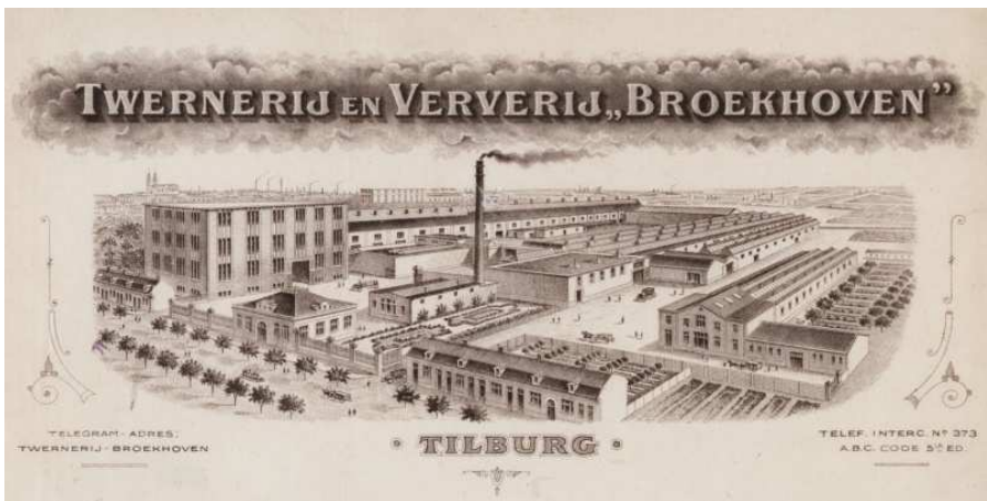
Afb. 1: de fabriek aan de Broekhovenseweg in 1922, met helemaal links het wolmagazijn uit 1919 dat nog steeds bestaat. 2)
