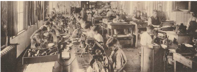
Afb. 10/11: de binnenzijde van de fabriek aan de achterkant van het hoofdgebouw 6)
