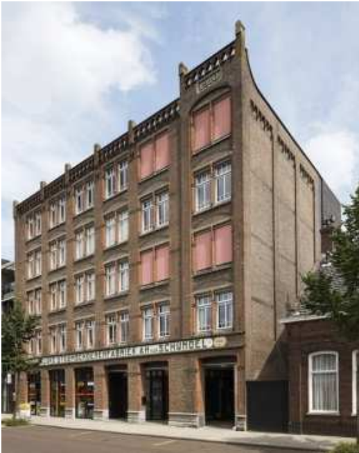
Afb. 15: het hoofdgebouw dat omgebouwd is tot appartementencomplex 9)
