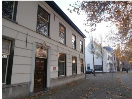
Afb. 5: het pand uit 1780 links van het kantoorpand 5)
