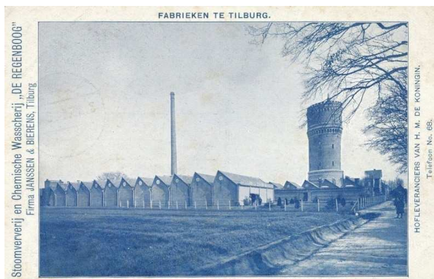
Afb 2 : De fabriek en watertoren aan de Bredaseweg*
